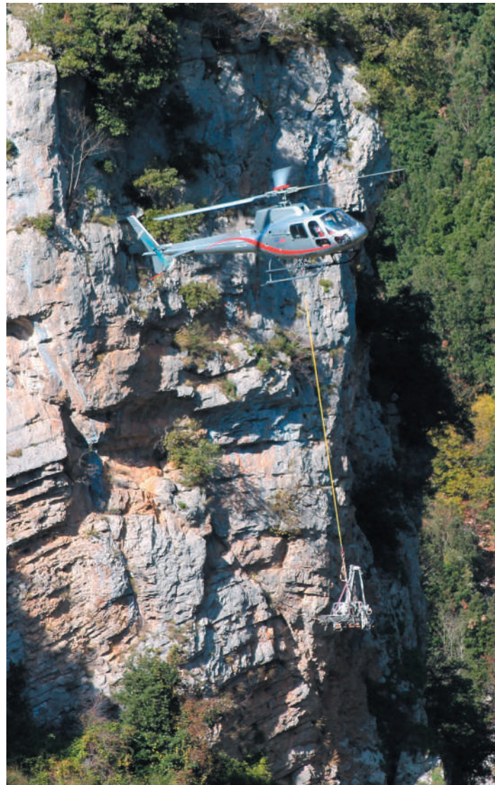
▼ Italcave Taranto Realizzazione chiodature profonde per il consolidamento del fronte scavato ▼ Italcave Taranto Deep nailing for the consolidation of the excavated front
