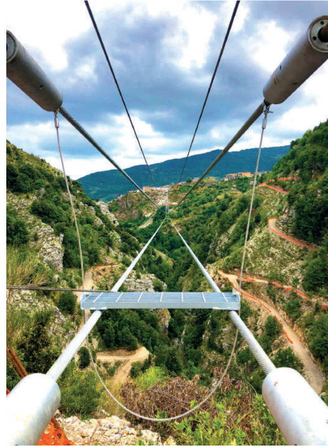
◀ Posa del primo gradino. Vista dalla stazione di arrivo
