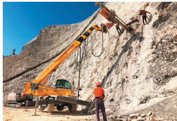
▼ Italcave Taranto Realizzazione chiodature profonde per il consolidamento del fronte scavato ▼ Italcave Taranto Deep nailing for the consolidation of the excavated front
