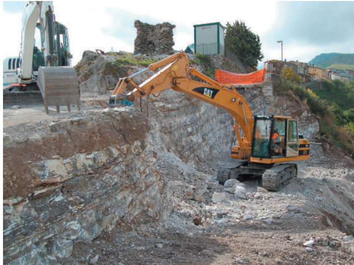
Lavori per la realizzazione del blocco di ancoraggio del ponte e della stazione di partenza
