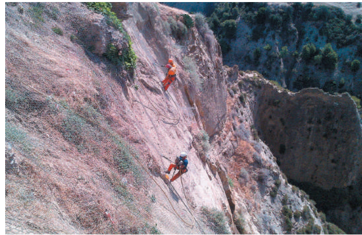
▼ Italcave Taranto Realizzazione chiodature profonde per il consolidamento del fronte scavato ▼ Italcave Taranto Deep nailing for the consolidation of the excavated front
